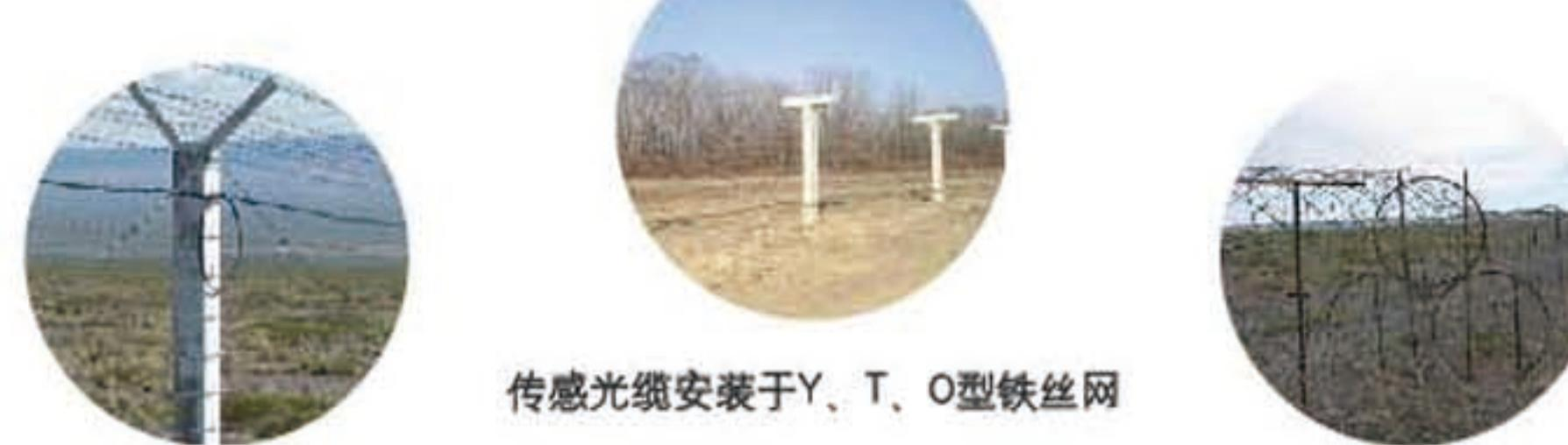
传感光缆安装于Y、T、O型铁丝网
